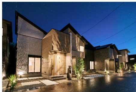
エスリードハウス八幡石清水
